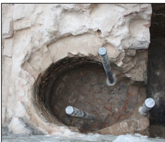
Fotografies 65 i 66. Estructura de combustió UE209 amb dipòsit UE207. Formen part adoberia finals s. XVIII-XIX.
