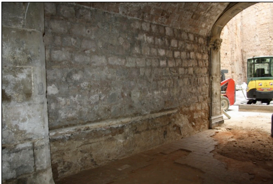
Fotografia 12. Vistes del mur UE109 amb restes de revestiment de calç.
