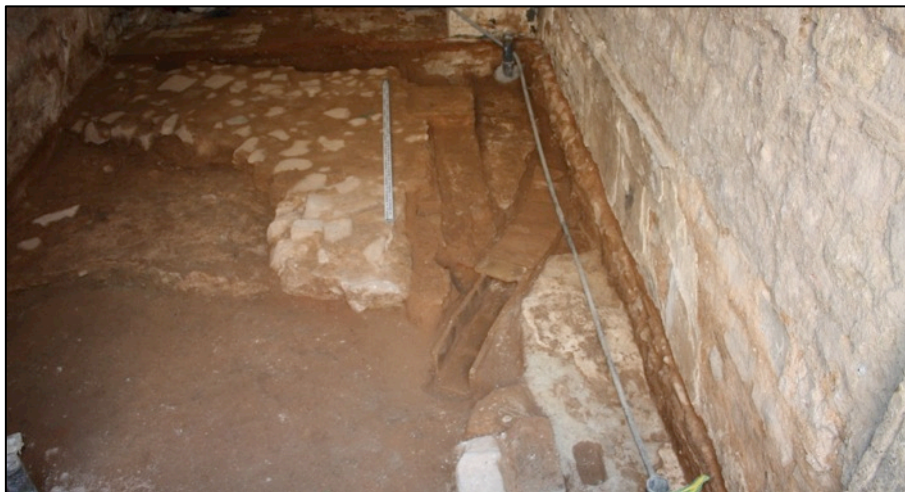
Fotografia 18. UE118 amb el mur UE127 afectats per claveguera UE124.
