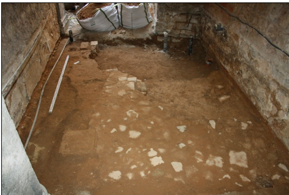
Fotografia 15. Preparació paviment UE118.
