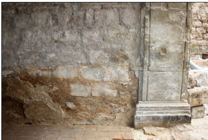
Fotografia 9. Detall mur nord corredor UE109 amb paviment UE104 juntament amb l'arcada d'accés.
