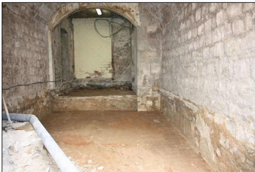
Fotografia 4. Vistes del corredor amb estructura del segle XIX UE105.
