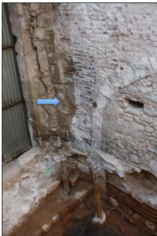
Fotografia 55. Línia de façana medieval UE189 integrada en mur s. XIX.
