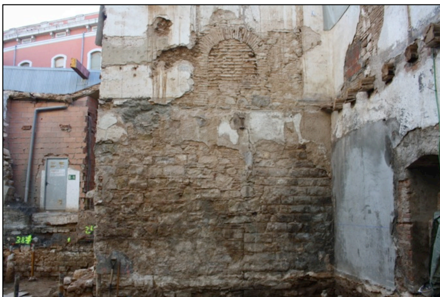
Fotografia 113. Estructura murària UE430.
