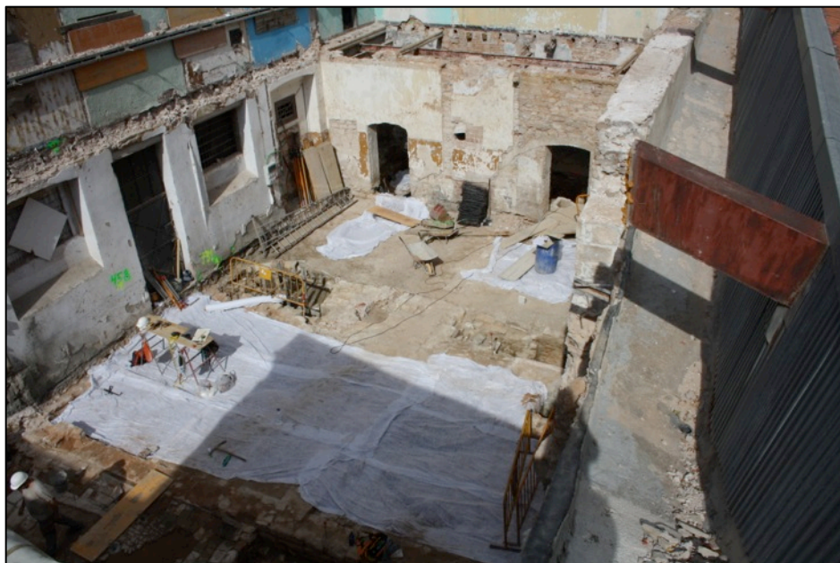
Fotografia 87. Cobriment estructures Tantarantana 15.
