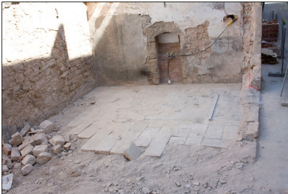
Fotografia 88. Vista paviment UE300.
