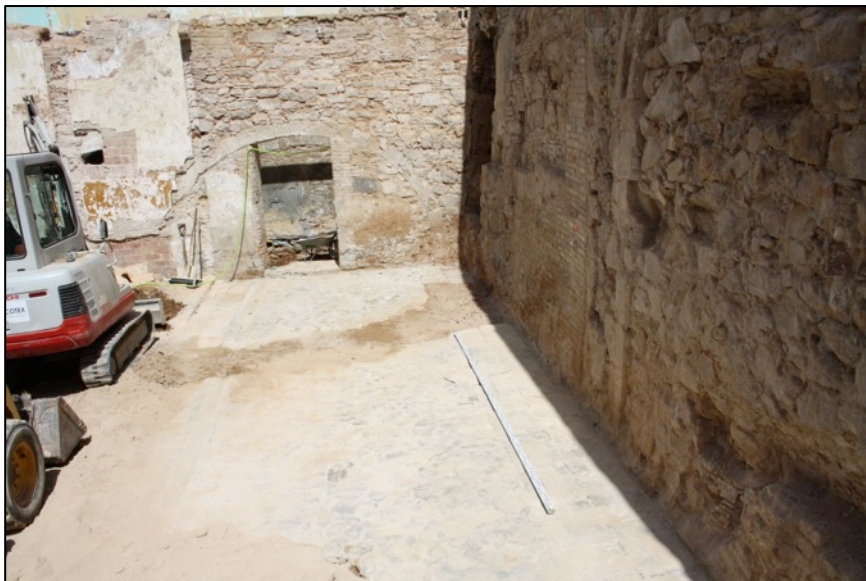
Fotografia 61. Vista paviment UE204.
