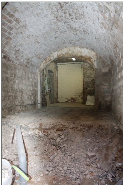
Fotografia 1. Vista del corredor abans d'iniciar els rebaixos de l'obra.
