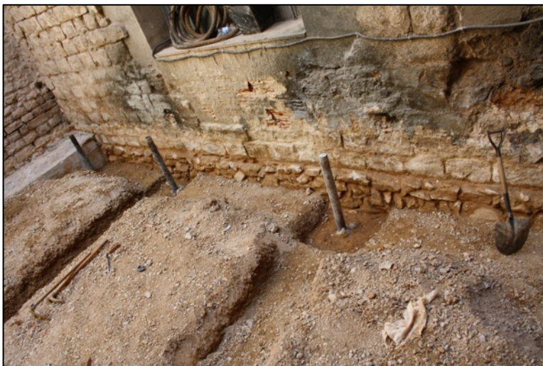
Fotografia 30. Vista mur Refectori UE150 un cop oberta la rasa nou per encepat.
