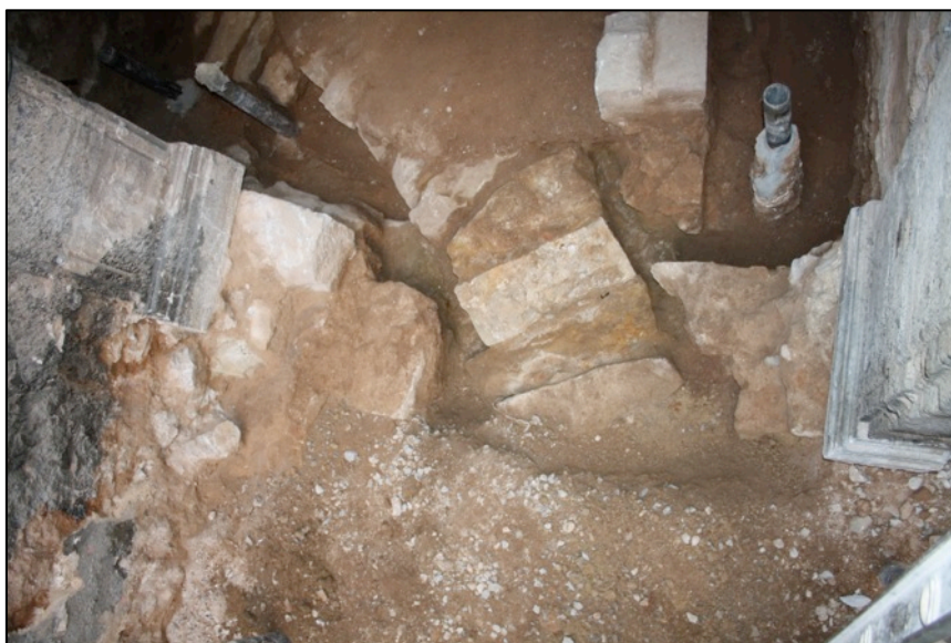
Fotografia 25. Vista de la claveguera s. XIX UE131 afectant murs UE147 i UE133.
